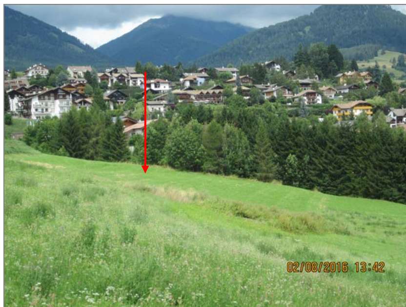
Fig.4: ubicazione emergenza a valle zona d'intervento
